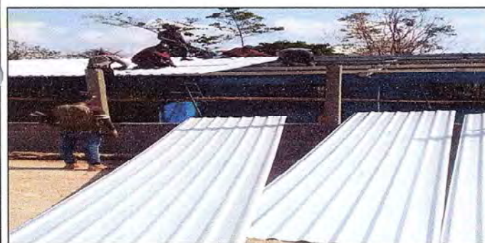
Foto 5: Entechado de aulas
