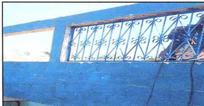
Foto 4: Colocación de balcones
