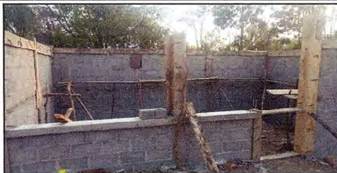
Foto 1: Reparación de la cocina.
