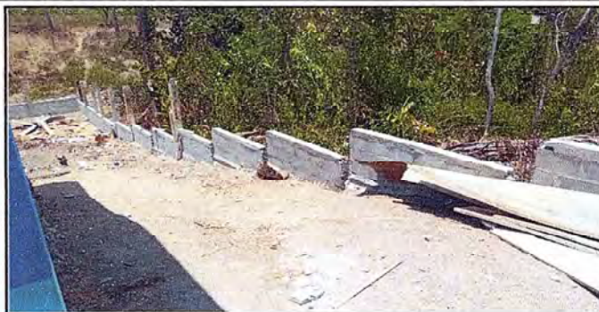
Foto 2: Realización del muro perimetral
