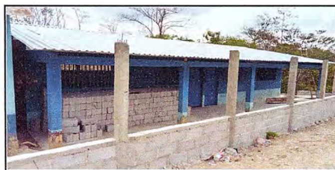
Foto 6: Colocación de maya a muro
