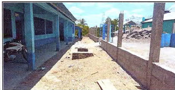
Foto 3: Colocación de Porton
